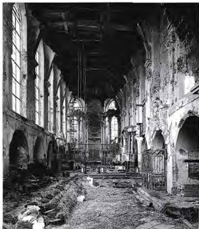
Die Zerstörungen von 1944.
