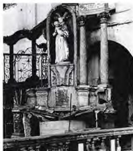
Schwer beschädigter südlicher Seitenaltar, nach 1944.
